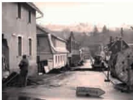
Verlegen von Telefonleitungen im Rasenmühlenweg, Herbst 1992
