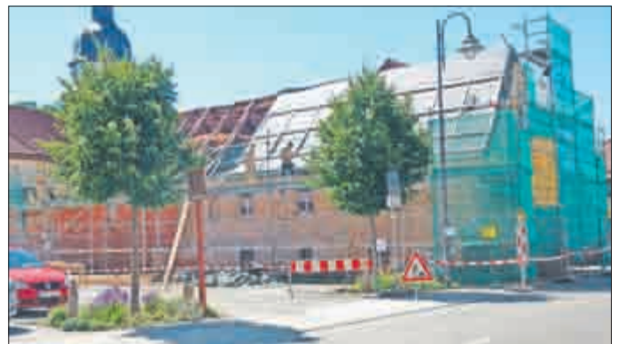
Mit der Sicherungsmaßnahme am Gebäude Hauptstraße 44 wird ein Beitrag zur Erhaltung und Nutzbarkeit eines der ältesten Gebäude in Steinbach-Hallenberg geleistet.
